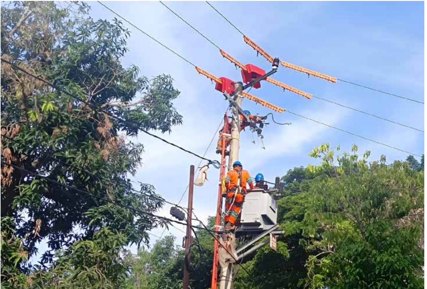
Tim Khusus Pekerjaan Dalam Keadaan Bertengangan tengah memelihara jaringan tanpa padam di Kabupaten Bantaeng, Sulawesi Selatan. (ANTARA/HO-PLN)
